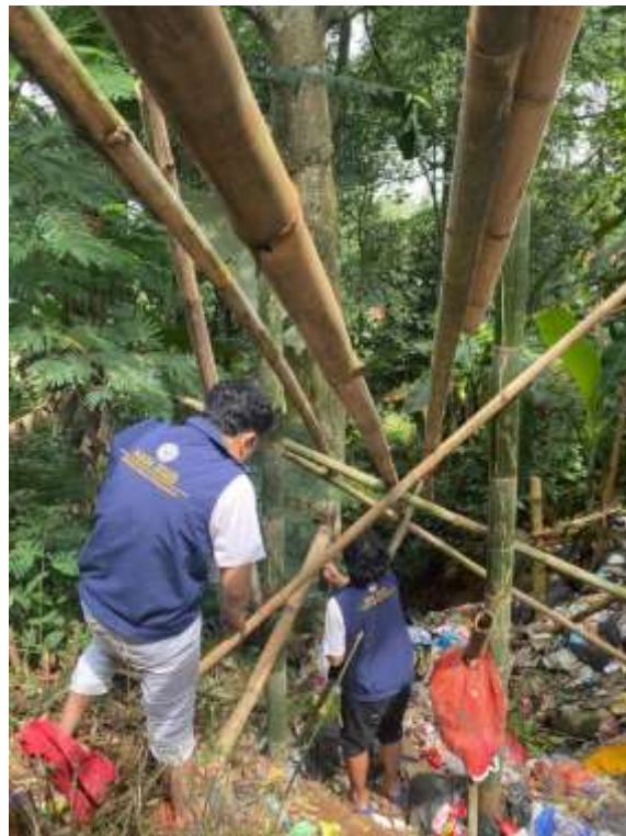
Gambar 3 : proses pembongkaran jembatan sampah yang rusak
